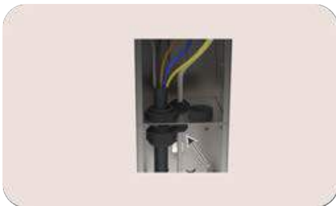
Afbeelding16: zicht op de openingen voor de kabeldoorvoer
